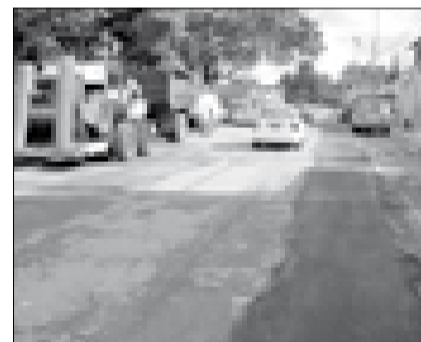
COLECTOR CARRERA 22 BARRIO OBRERO
